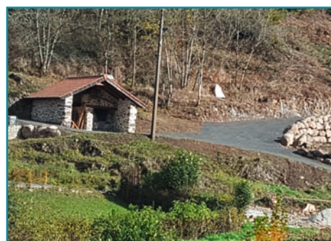
Aménagement de la plateforme autour du four à pain communal
