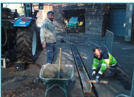
Pose de bordures et de caniveaux place du 19 mars 1962
