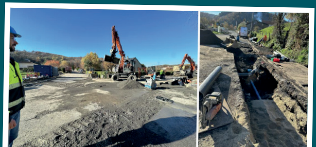
DÉCEMBRE - Mise aux normes des systèmes d'assainissement rue Pierre Marty
