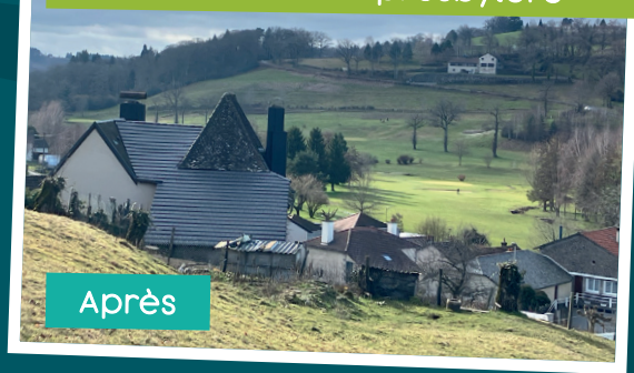
28 MARS - élagage des arbres rue de l'Abbé Lauzet et changement toiture ancien presbytère
